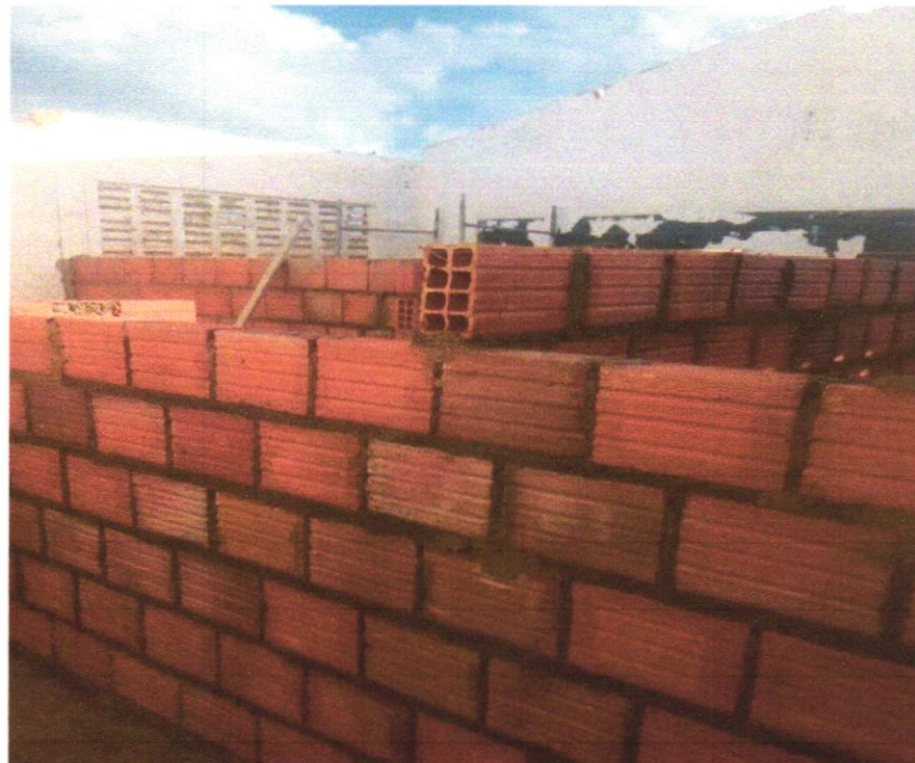
FOTO 06 – ALVENARIA DE VEDAÇÃO DE BLOCOS CERÂMICOS FURADOS NA HORIZONTAL DE 9X19X29 CM (ESPESSURA 9 CM) E ARGAMASSA DE ASSENTAMENTO COM PREPARO EM BETONEIRA. AF_12/2021
