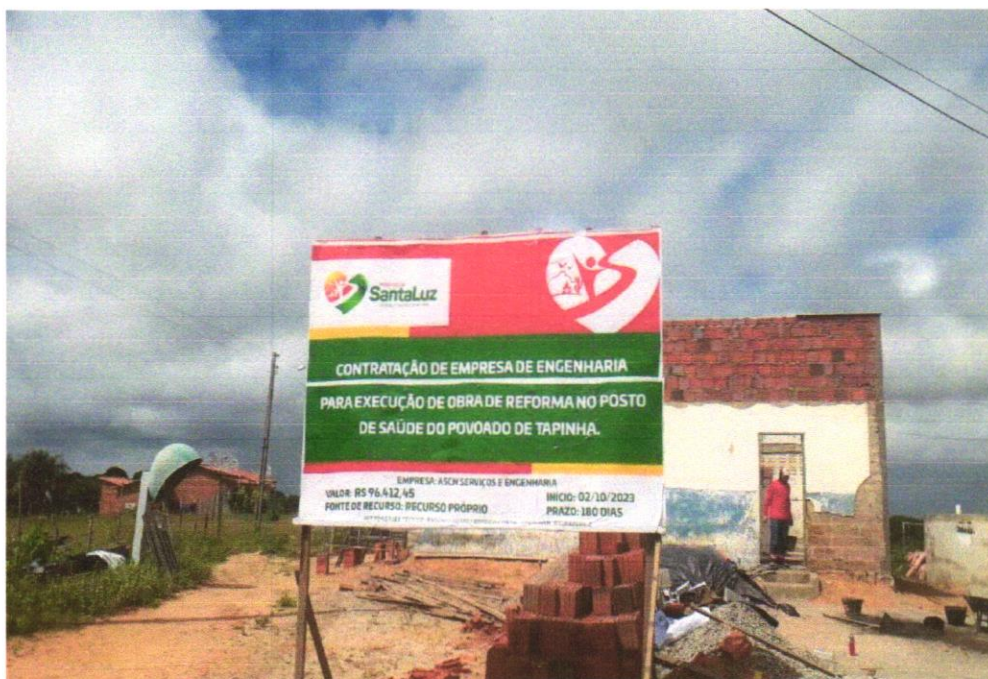
Foto 17 - Placa de obra em chapa aço galvanizado, instalada - Rev 02_01/2022
