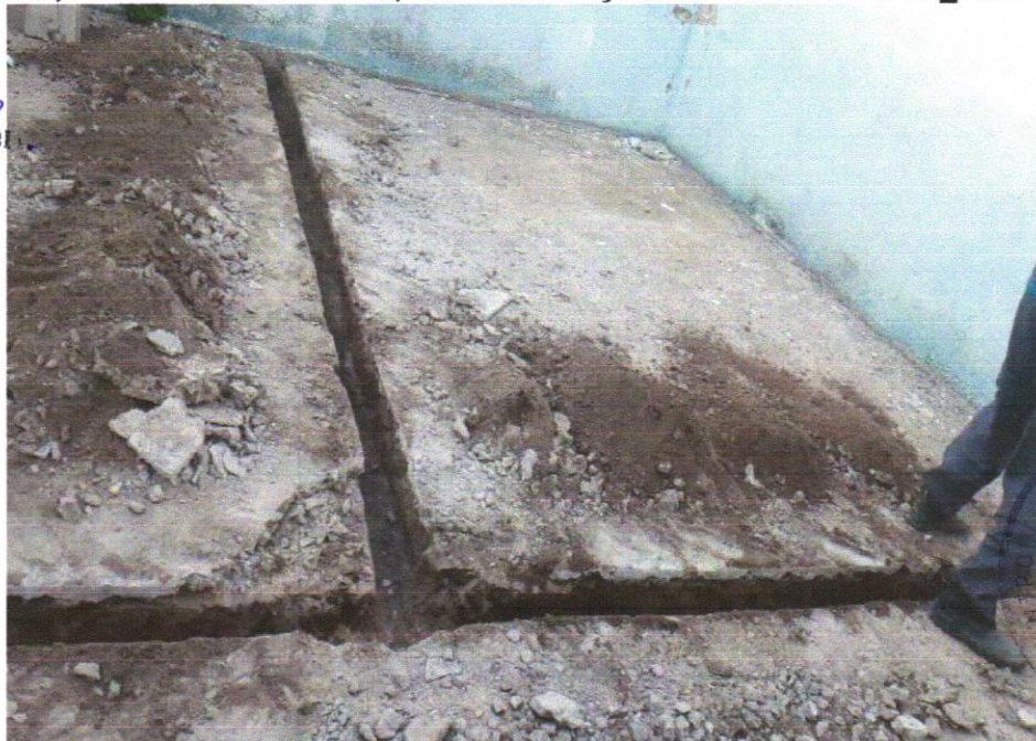
FOTO 14 - ESCAVAÇÃO MANUAL DE VALA PARA VIGA BALDRAME (INCLUINDO ESCAVAÇÃO PARA COLOCAÇÃO DE FÔRMAS). AF_06/2017
