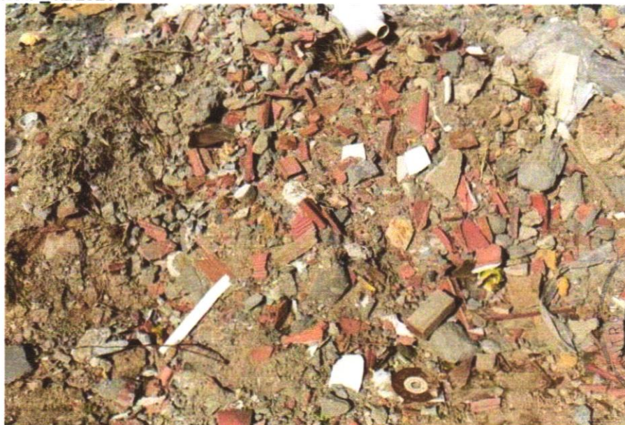
FOTO 08 - DEMOLIÇÃO DE ALVENARIA DE BLOCO FURADO
