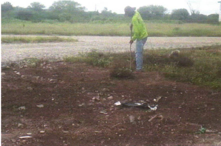
Foto 19- LIMPEZA MANUAL DE VEGETAÇÃO EM TERRENO COM ENXADA.AF_05/2018
