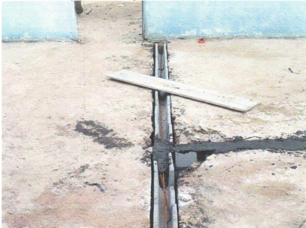
FOTO 16 Bloco cerâmico tipo "u" (calha) 9x19x19cm
