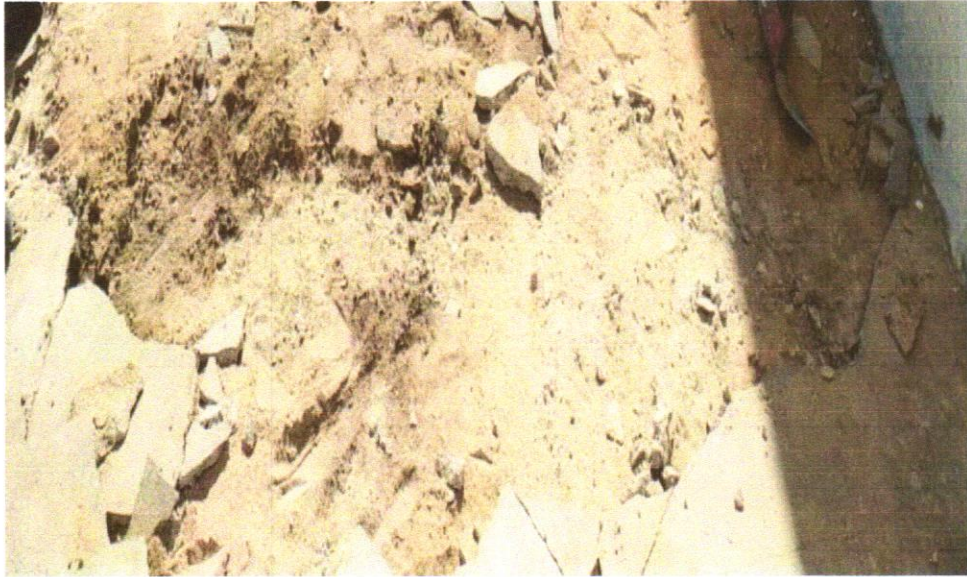
FOTO 15 Demolição manual de piso cimentado sobre lastro de concreto - Rev 01
