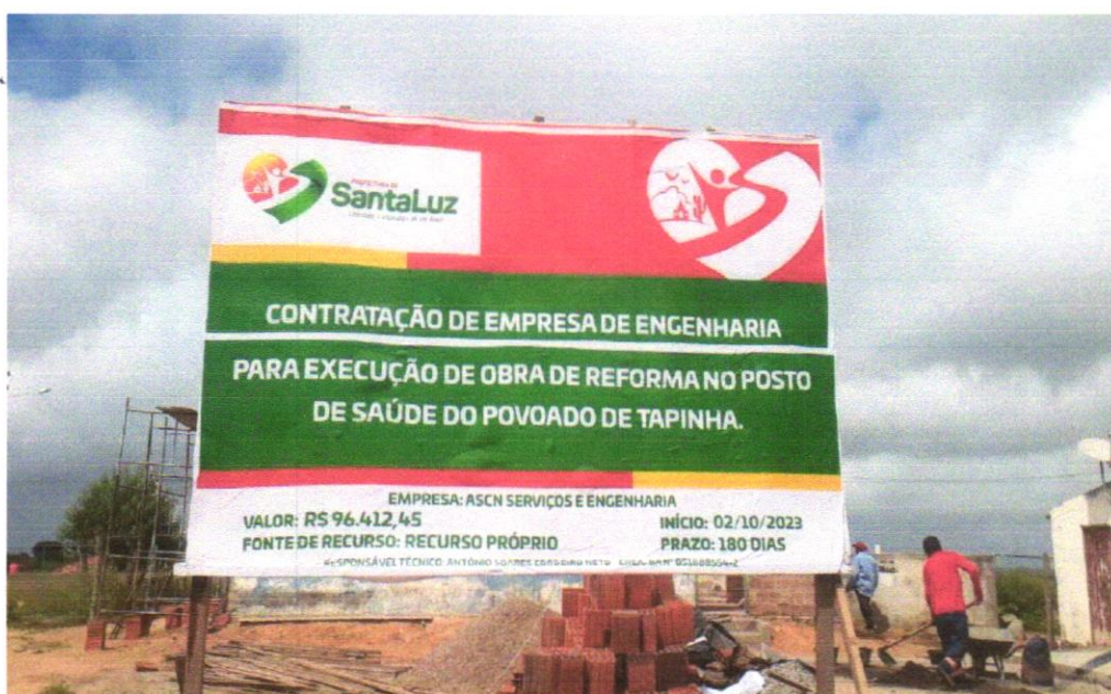
Foto 18 - Placa de obra em chapa aço galvanizado, instalada - Rev 02_01/2022
