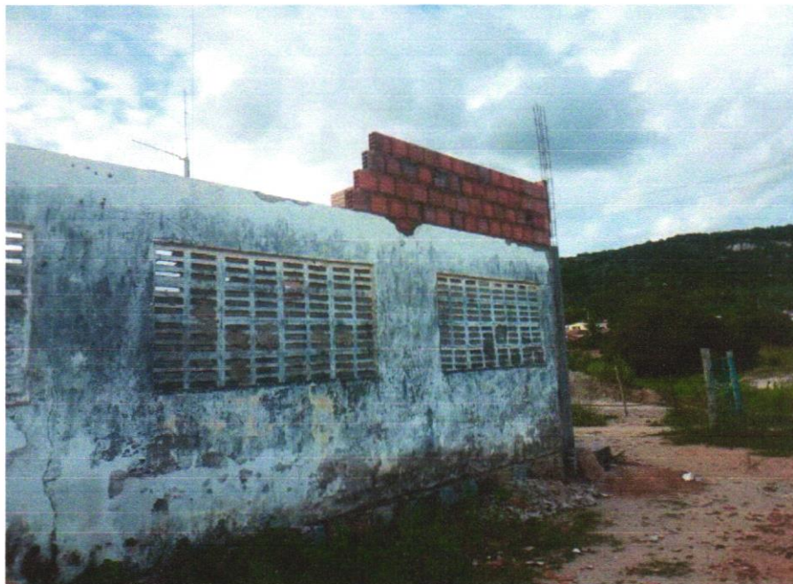
FOTO 09 – ALVENARIA DE VEDAÇÃO DE BLOCOS CERÂMICOS FURADOS NA HORIZONTAL DE 9X19X29 CM (ESPESSURA 9 CM) E ARGAMASSA DE ASSENTAMENTO COM PREPARO EM BETONEIRA. AF_12/2021
